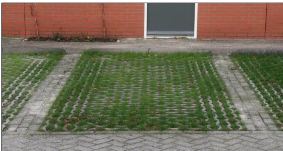
Figuur 9: Halfverharding bij parkeerplaatsen (bron:duurzaamdenhaag.nl).
