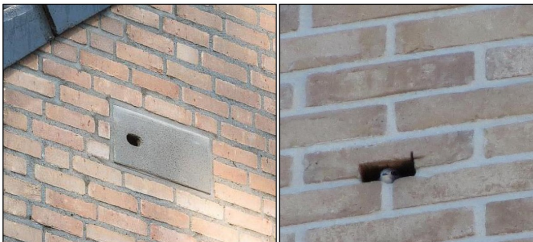
Figuur 2: Inmetzelstenen zichtbaar (links) en onzichtbaar (rechts) in de gevel verwerkt (bron: Vivarapro).
