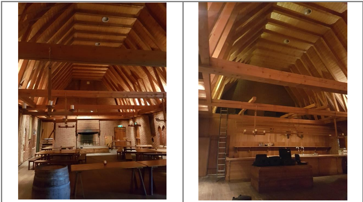
Figuur A.3 Binnenzijde feestzaal, houten spanten en dak beschot, podium (links) en bar (rechts)
