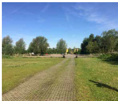
Parkeervelden zijn groen ingericht met een halfverharde rijbaan.
