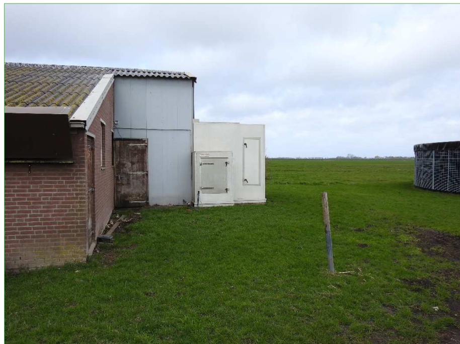
De achterzijde van de noordelijk gelegen langwerpige varkensstal met de aangebouwde luchtwasser. Aan de rechterkant is een deel van de mestsilos zichtbaar.
