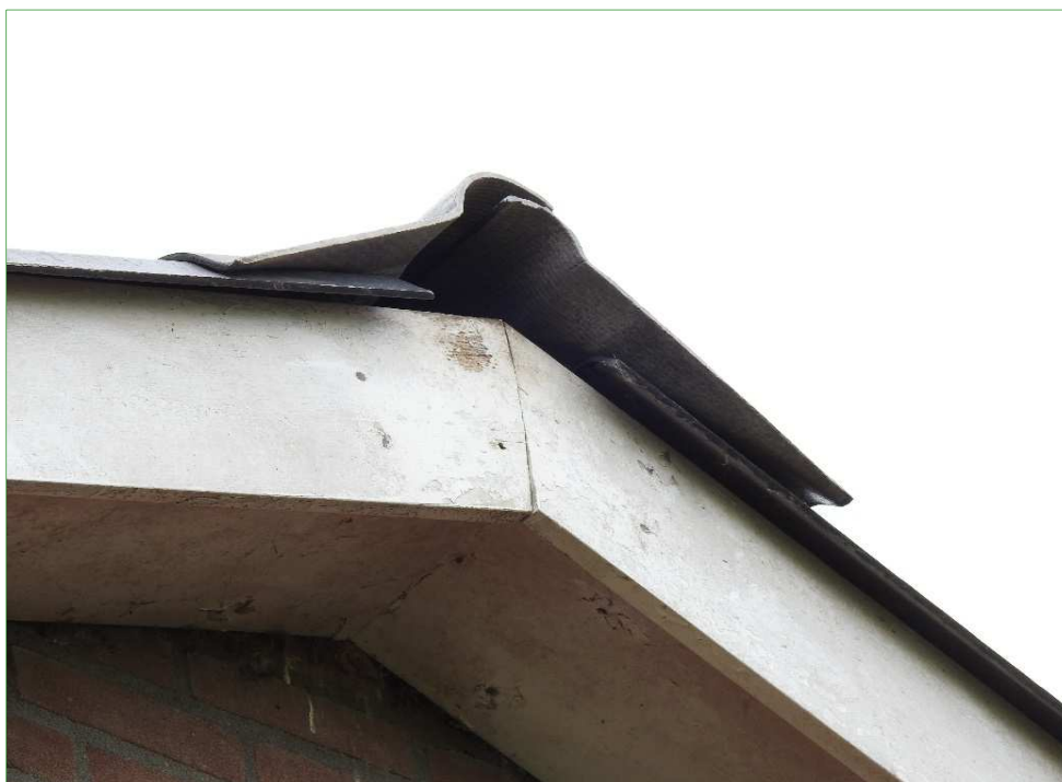
De nok van de vierkante varkensstal waarbij een duidelijke toegangsopening aanwezig is voor vogels.
